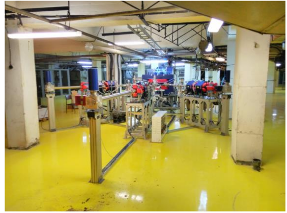
Подвал экспериментального зала с тремя протонными трактами к мишенным станциям РИЦ-80
